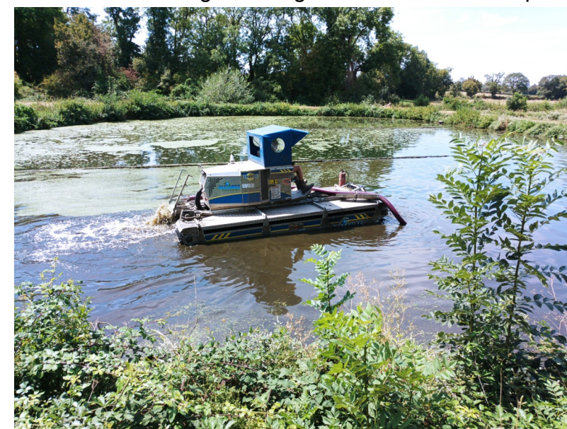
Pompage et transfert des boues vers les bassins 2 et 3
