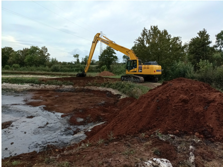
Curage des boues hygiénisées avant épan-dage
