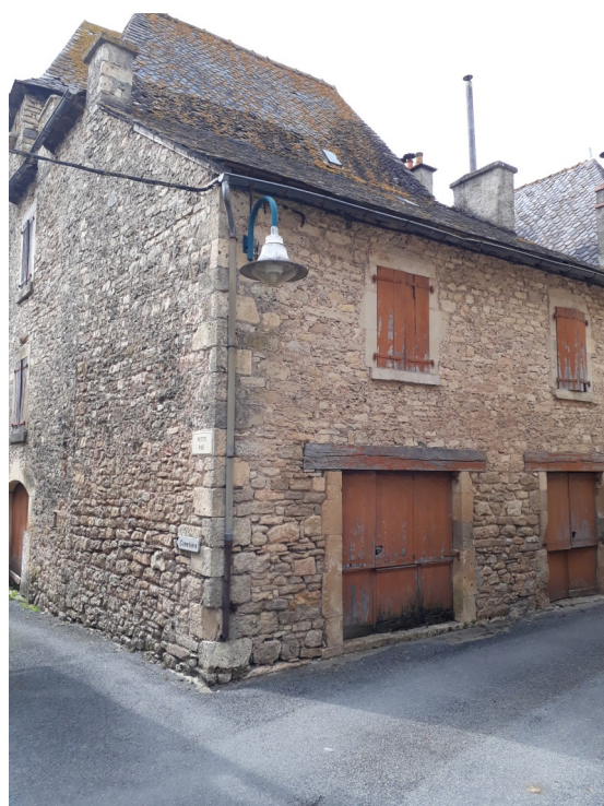
Avant la démolition
